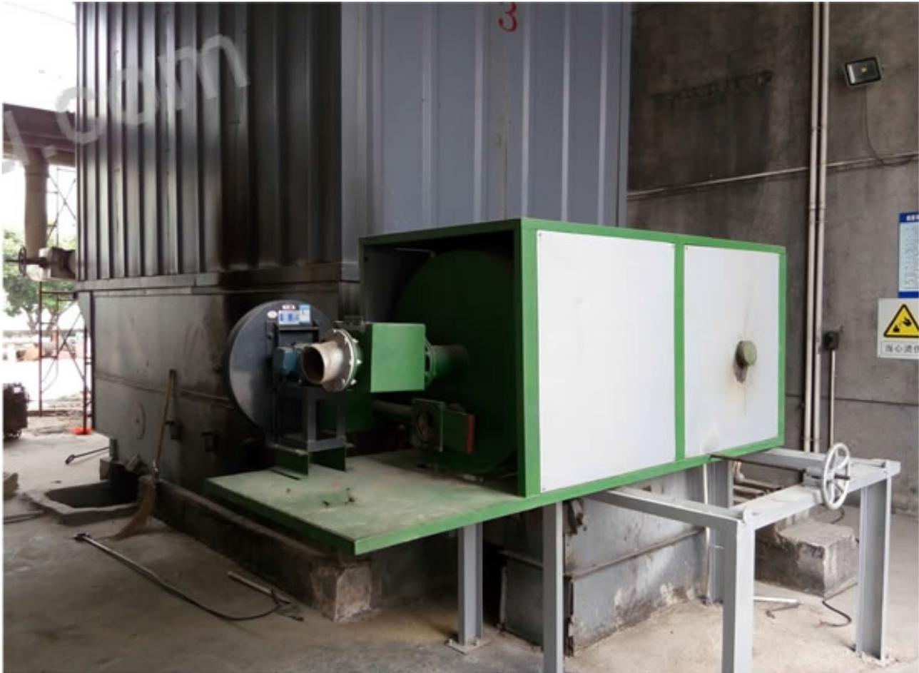
图 1 生物质粉体燃料燃烧机
